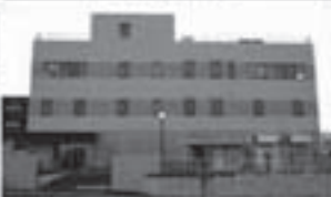
データセンター
