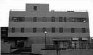
データセンター
