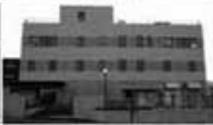
データセンター
