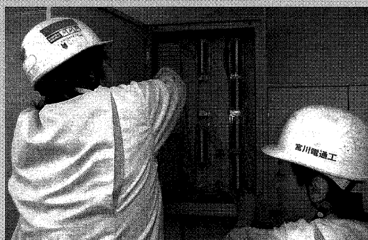
光回線配電盤工事
