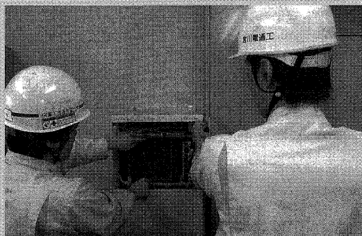
交換機パッケージ搭載作業
