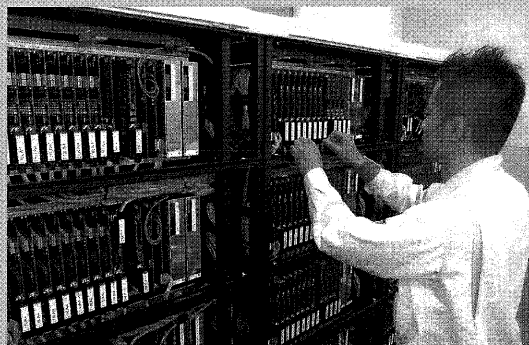
交換機配線作業
