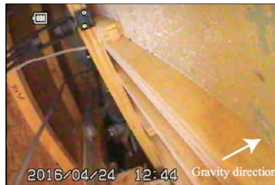
屋根裏の状況
